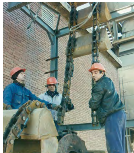
Montaggio catena per elevatore Assembly of an elevator chain Montaje cadena para elevador
